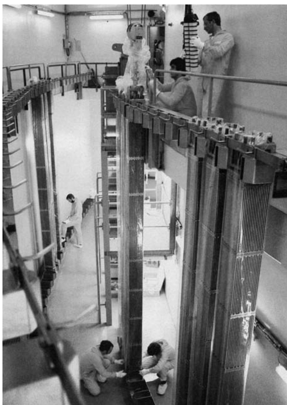
Fot. 4. Kasety paliwowe typu PWR w EJ Graffenrheinfeld (źródło: Helmut F.Albrecht/Rainer Kiedrowski. Kernenergie in Deutschland. Ein Bildatlas/Ullstein)
